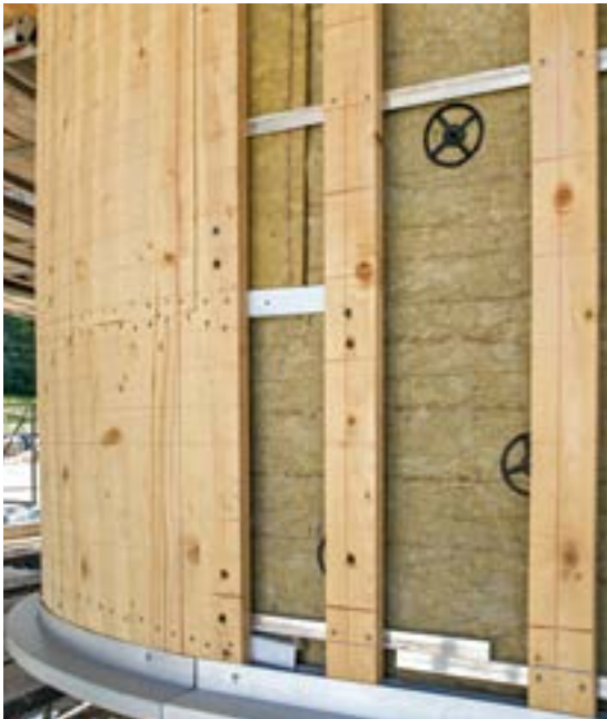
Für die Dämmung der runden Ecken stellte die Flumroc AG Spezialanfertigungen her.
