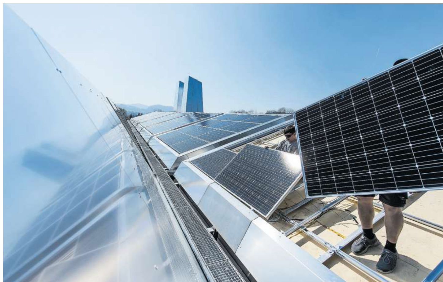
Wärme und Strom in einem: Auf dem Dach der Fernwärmezentrale Waldau wurde eine Solaranlage installiert.
