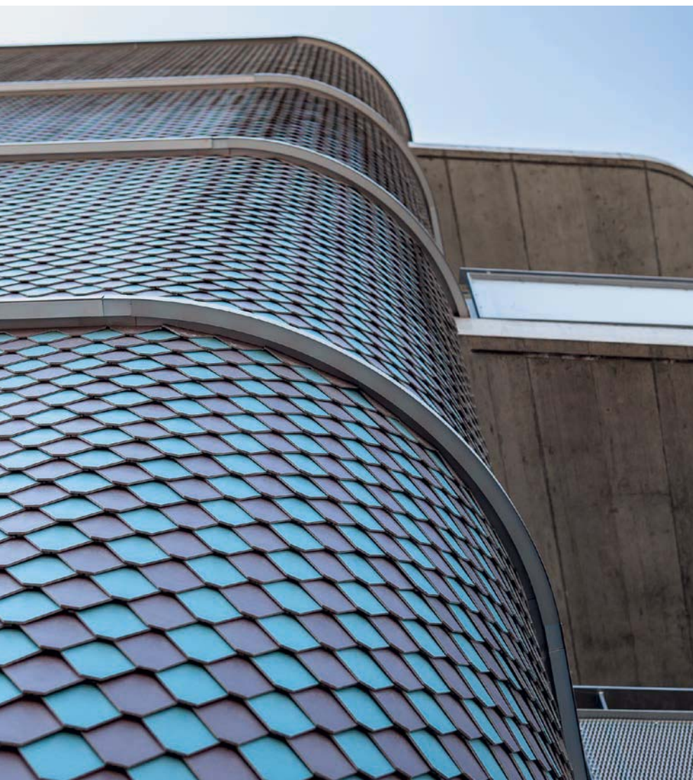
An den zahlreichen Rundungen wurde die Aussenhaut mit Einzelschindeln ausgeführt. Das durchlaufende Muster verlangte höchste Präzision.
