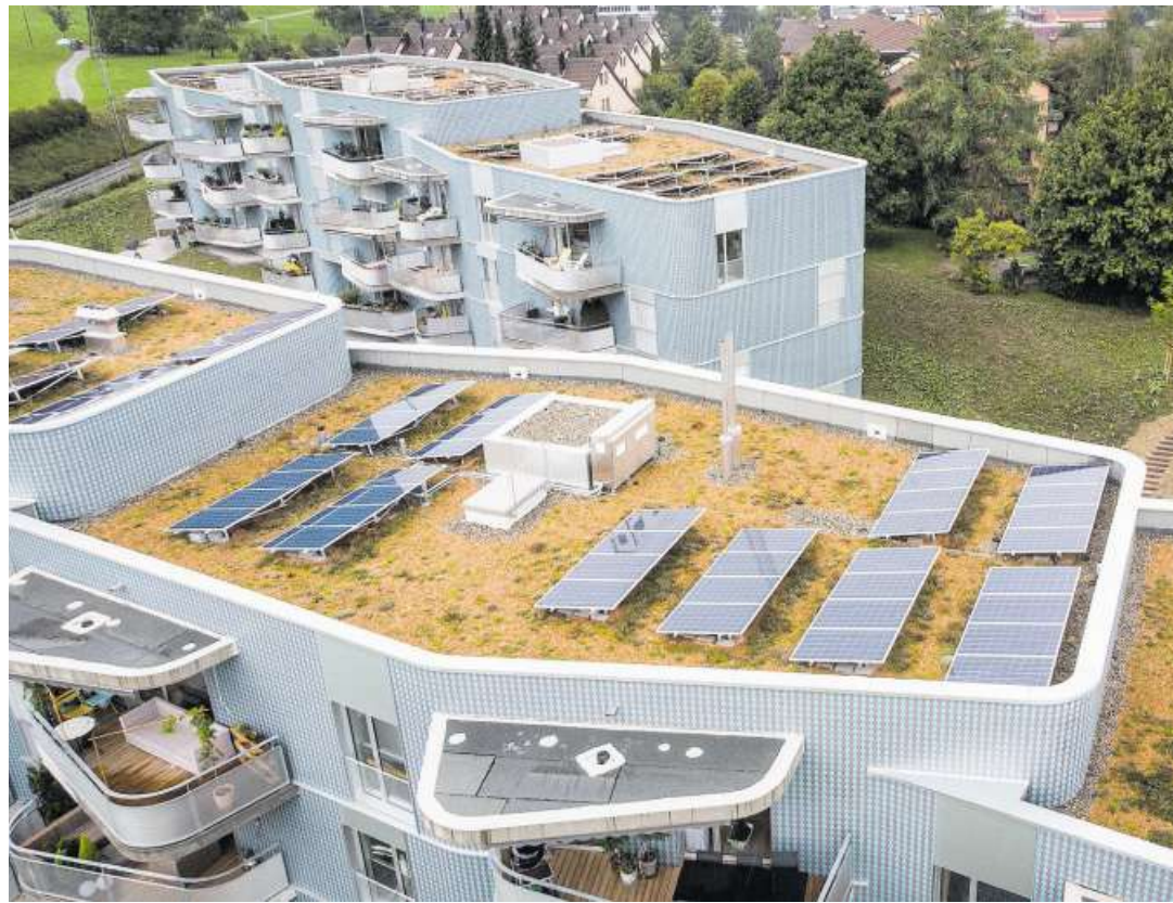
Die Siedlung Sturzenegg ist mit Fotovoltaikanlagen auf dem Dach ausgestattet.
